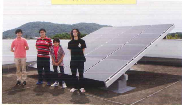
本学設置の太陽パネル
