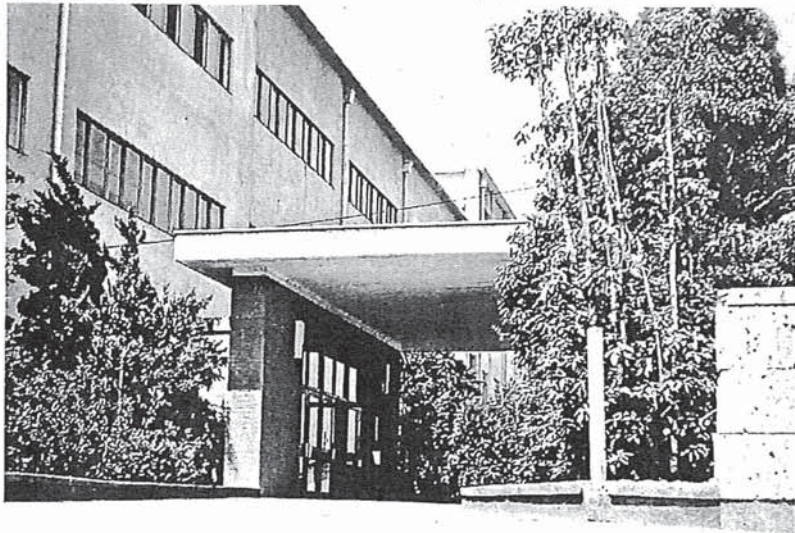
モノづくりの基礎を学んだ県立徳島東工業高校。現在は統合されて校舎は残っていない
